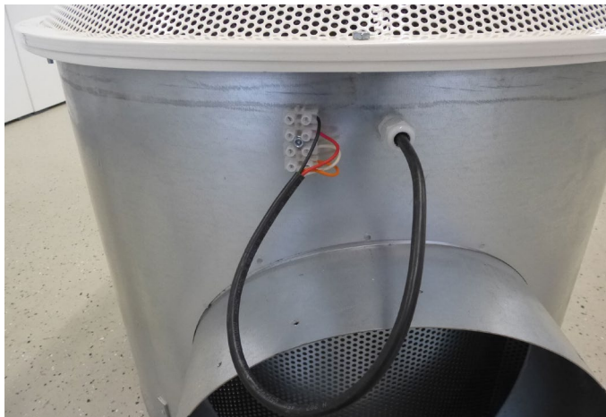
Abb. 16. Herstellen der elektrischen Verbindung
