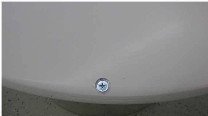
Abb. 11. Befestigungsschraube Leitelement
